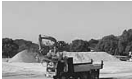
コンクリートがらを一定の大きさに砕いて、碎石として再生利用することにより現場内リサイクルをしています。
