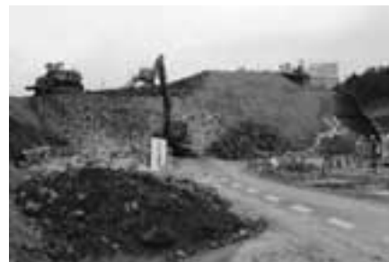
既設構造物の鉄筋、鋼線などとコンクリートとを分別しています。
