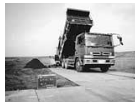
高規格堤防に運搬して盛土に利用
