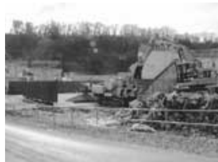
現場内に破砕機を設置して、コンクリートがらを砕石に加工しています。
