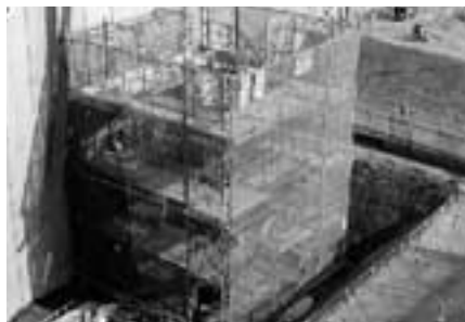
内側に鋼製の筒（コルゲート）（直径1m、延長15m、2ヶ所）を埋め込んで、外側にコンクリートを流し込みます。
