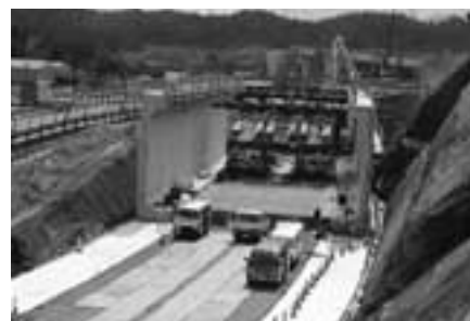
構造物（ボックスカルバート）の一部（側壁の部分）に、プレキャスト化したものを用いています。
