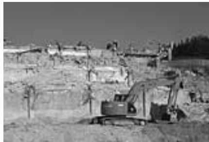
建物(中央管理棟)を取壊しています。大量のコンクリートがらが生じます。
