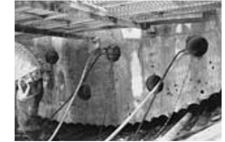
油圧ジャッキ(パースター)挿入、クラック発生前
