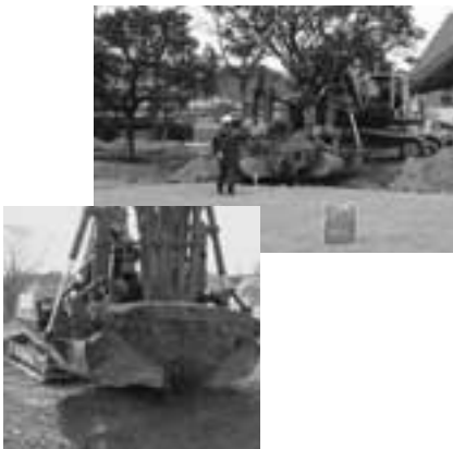
樹木に負担をかけないよう、素早く移植します。根のまわりの土もそのまま移動しています。このような機械を使えば枝葉も幹も痛みません。
