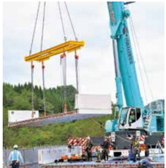
コッター床版架設(壁高欄一体型)
