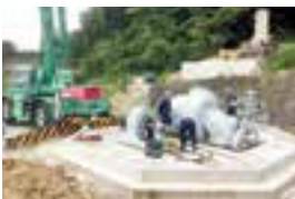
施工中の状況
