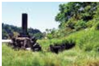
施工前の状況
