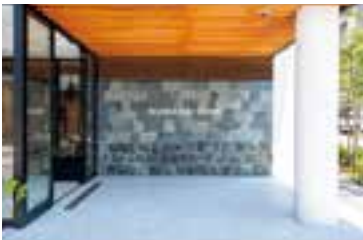
正面入り口付近：正面壁の下部には「宿布発電所」で実際に使われていた積み石が再利用されている
