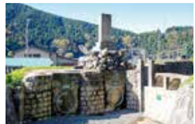
完成後の状況
