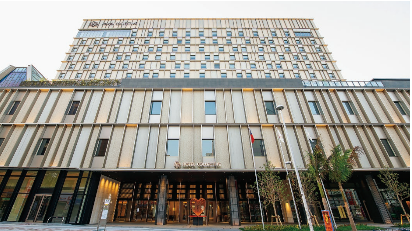
外観正面(国際通り沿い)
