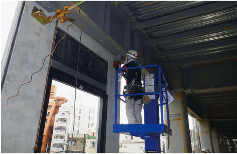
PC板取り付け状況
