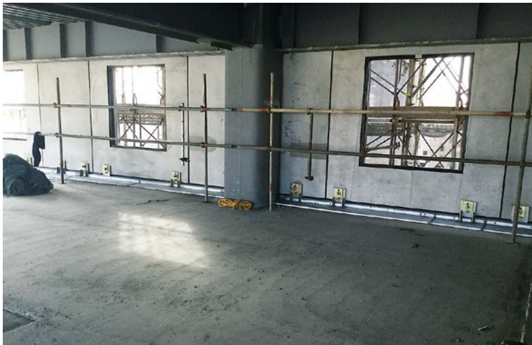
PC板建て込み状況(内部より)
