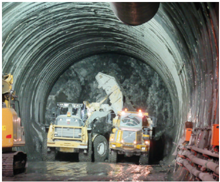
スリ出し状況
