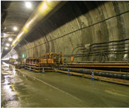
坑内の側部に配管された複数のパイプで水を外へ汲みだす
