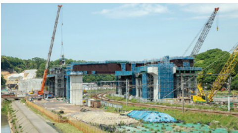
施工状況(手前福井駅方面)
