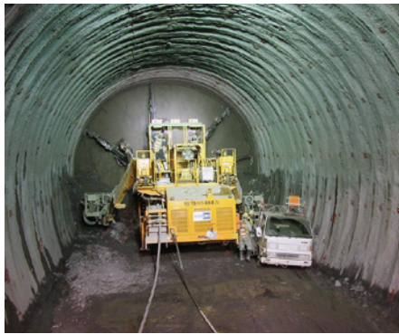
ロックボルト削孔状況
