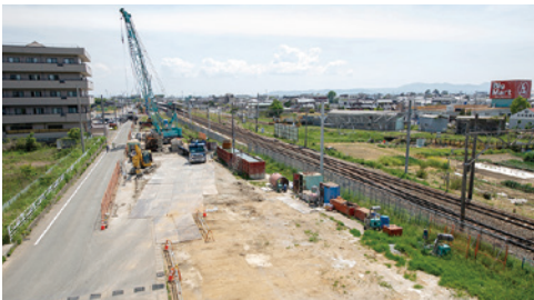
施工状況(手前金沢駅方面)
