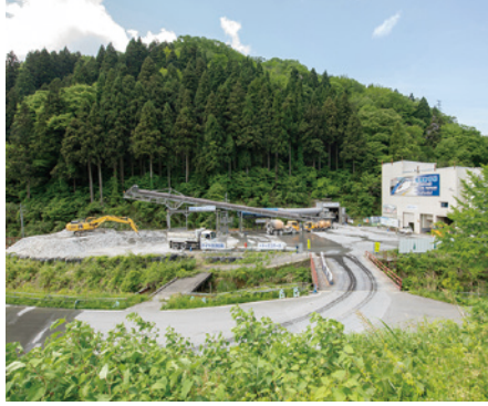
新北陸トンネル斜坑口付近外観
