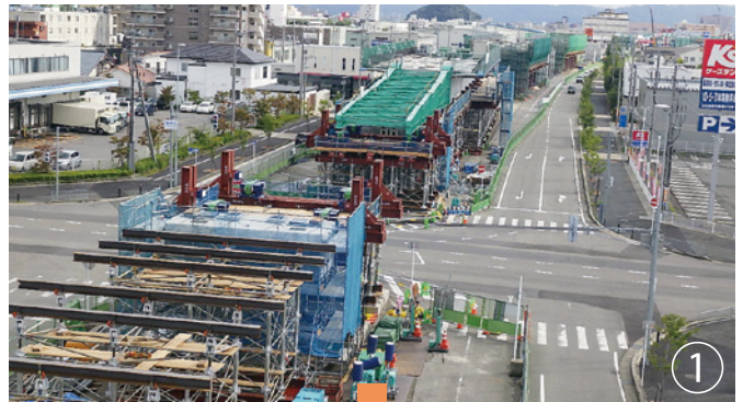
「押し出し工法」施工前
