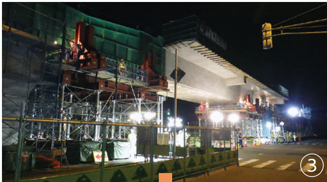
深夜施工完了
