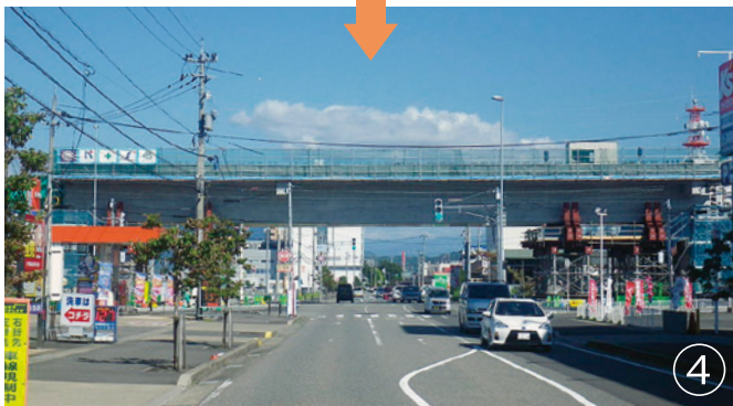
施工後の状況
