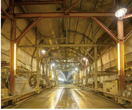
掘削後に防水シートを施工
