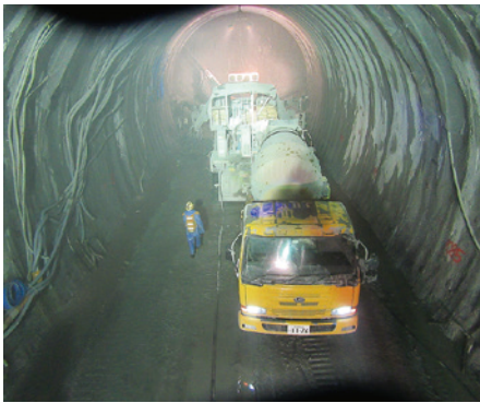
吹き付けコンクリート状況
