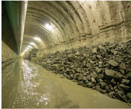
トンネル内のずりを集めて細かく砕きベルトコンベアーにて坑外に搬出
