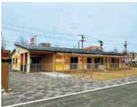
病院職員向け保育所棟
