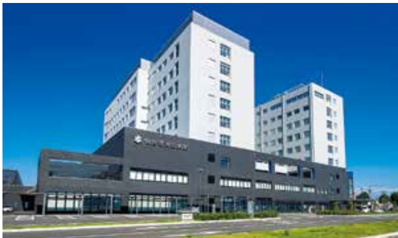
全景：南東面(手前駐車場側より)
