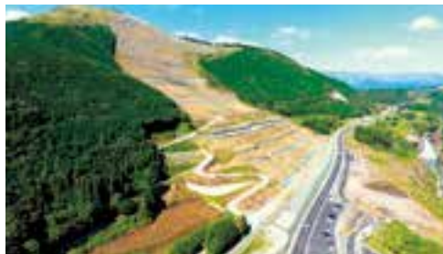
阿蘇大橋地区斜面災害復旧工事
