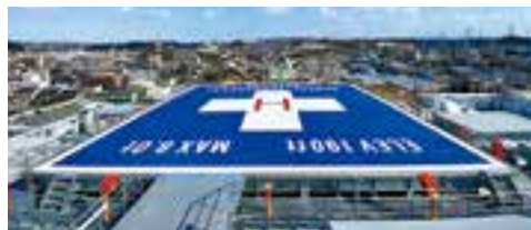
屋上ヘリポート
