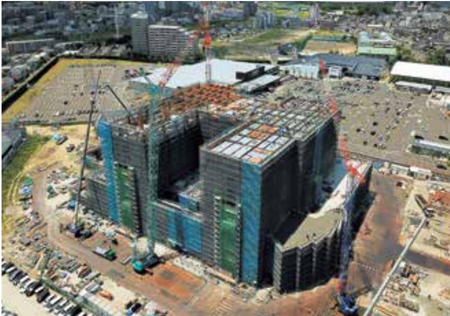
躯体工事施工状況(令和3年7月)
