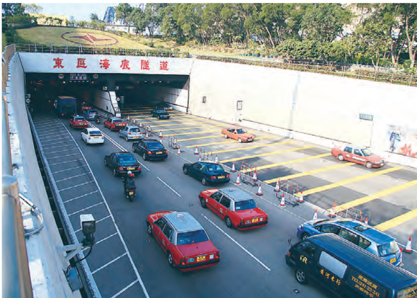
EHC(香港東部海底トンネル)-2016年現在
