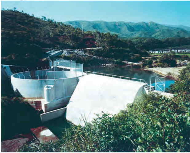
プロパーコープ水道トンネル
