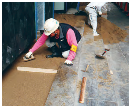
道路改修工事：敷砂均し作業
