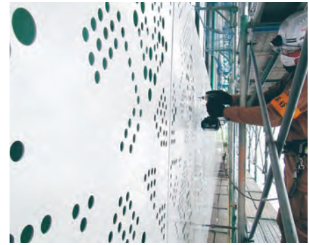
アルミバンチングパネル取り付け作業状況
