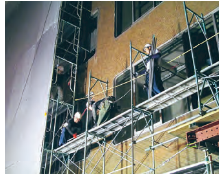
夜間：外部足場組立作業状況（中央通り面）
