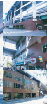
着工前の各館外観風景
