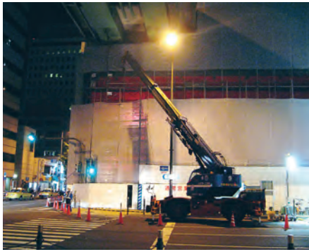
夜間：鉄骨建方作業状況（御堂筋面）
