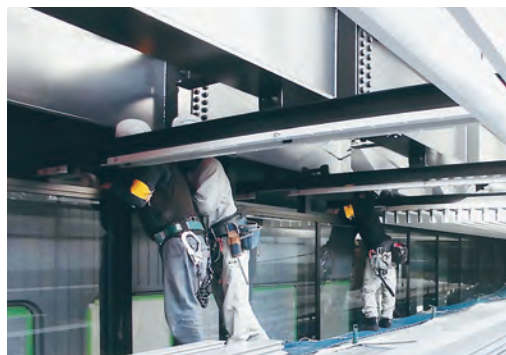
筋部アルミバー取り付け作業状況
