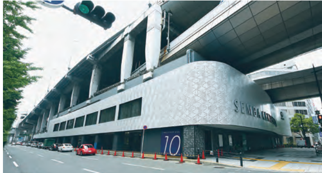
10号館南面(改修後)
