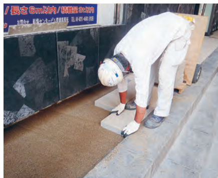
道路改修工事：コンクリート平板敷設作業
