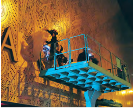
夜間：箱文字サイン取付作業状況（堺筋面）
