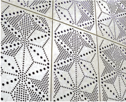
パネル取り付け完成の外観
