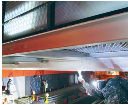
夜間：車道上部天井塗装作業状況
