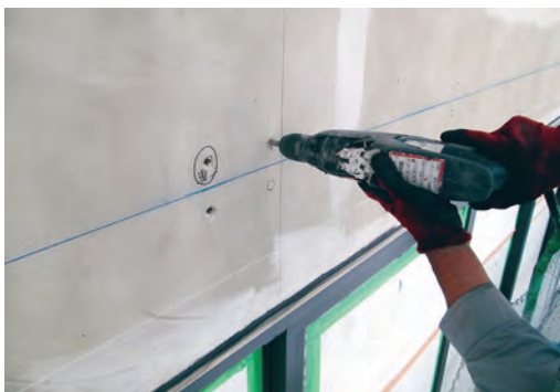
アルミパネル 下地アンカー穿孔作業状況
