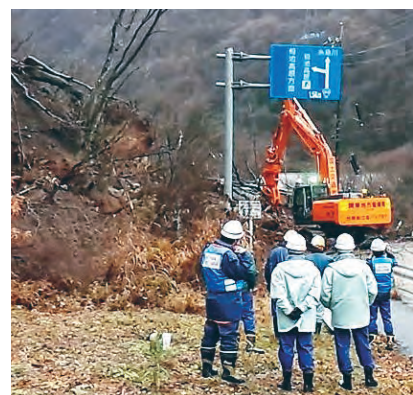
復旧作業の様子
