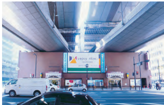
着工前:10号館東面
