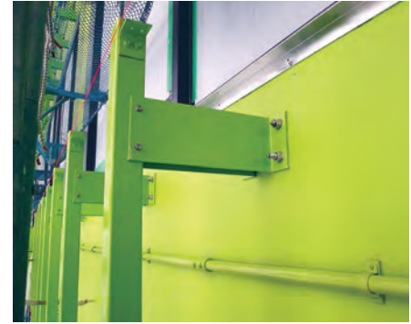
アルミバンチングパネル取り付け完了(中央通り面・堺筋面)
