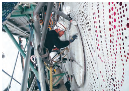
ロゴマークサイン取り付け作業状況（堺筋面）
