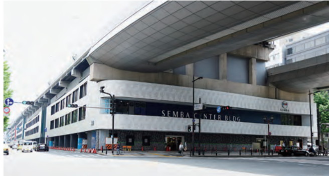
9号館北面(改修後)
