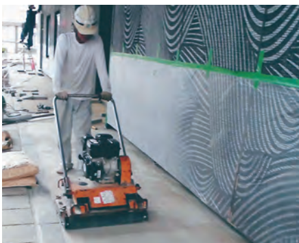
道路改修工事：コンクリート平板転圧作業
