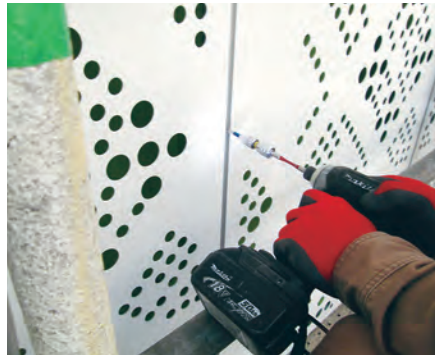
アルミバンチングパネル取り付け作業状況
