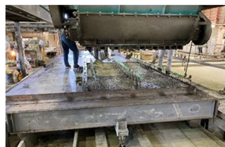
写真2 工場での製作状況
