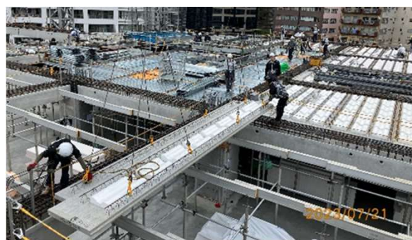
写真3 適用対象(現場施工状況)
