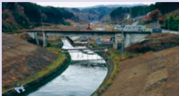
桜川橋梁下流側より（着工前）
