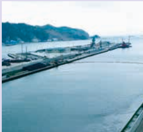
甲子川水門（着工前）
