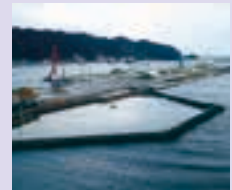
自然災害による水没で施工が中断
