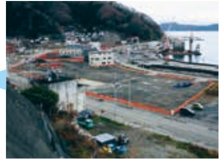
東部浜町 水産加工団地・造成工事状況 (2014.12)
