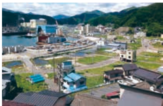
東部地区東側 東前～浜町・着工前 (2014.6)
