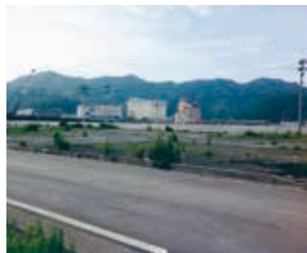
嬉石松原地区 現区10-3路線3号公園・着工前 (2013.7)
