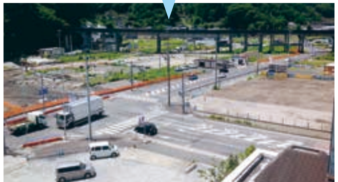
国道283号迂回路変更・着工前 (2014.6)
