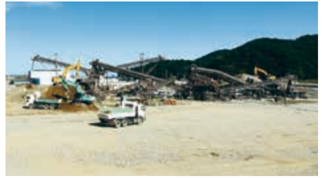
平田地区仮置場盛土材受入プラント（2017.9）
