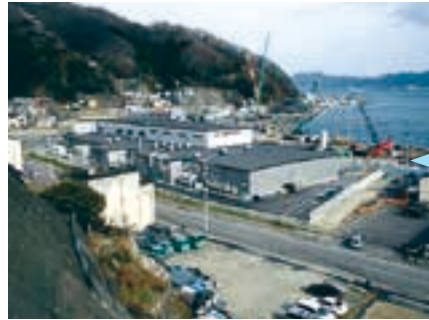
造成工事完成後 (2017.1)
