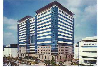
■聯華電子 (UMC) 本部ビル 世界的な半導体メーカー聯華電子 (UMC) 社の本部ビルや工場を施工。
