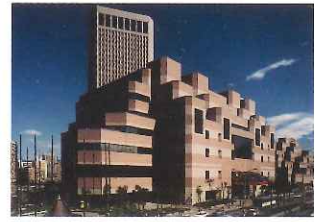
■台北世界貿易センター 台北国際貿易ビルと国際会議センターを施工。
