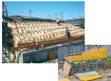
くし型スラブ型枠のモックアップ
