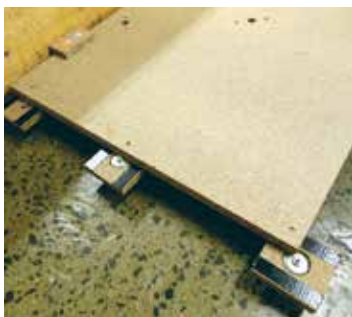
パーティクルボードと支持脚施工
