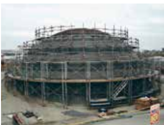
トラスウォール据付完了・コンクリート打設前状況
