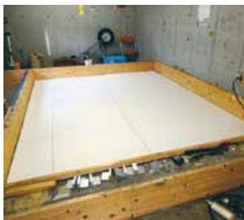
ガラス繊維不織布入りせっこう板施工
