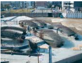
トラスウォール資材搬入状況
