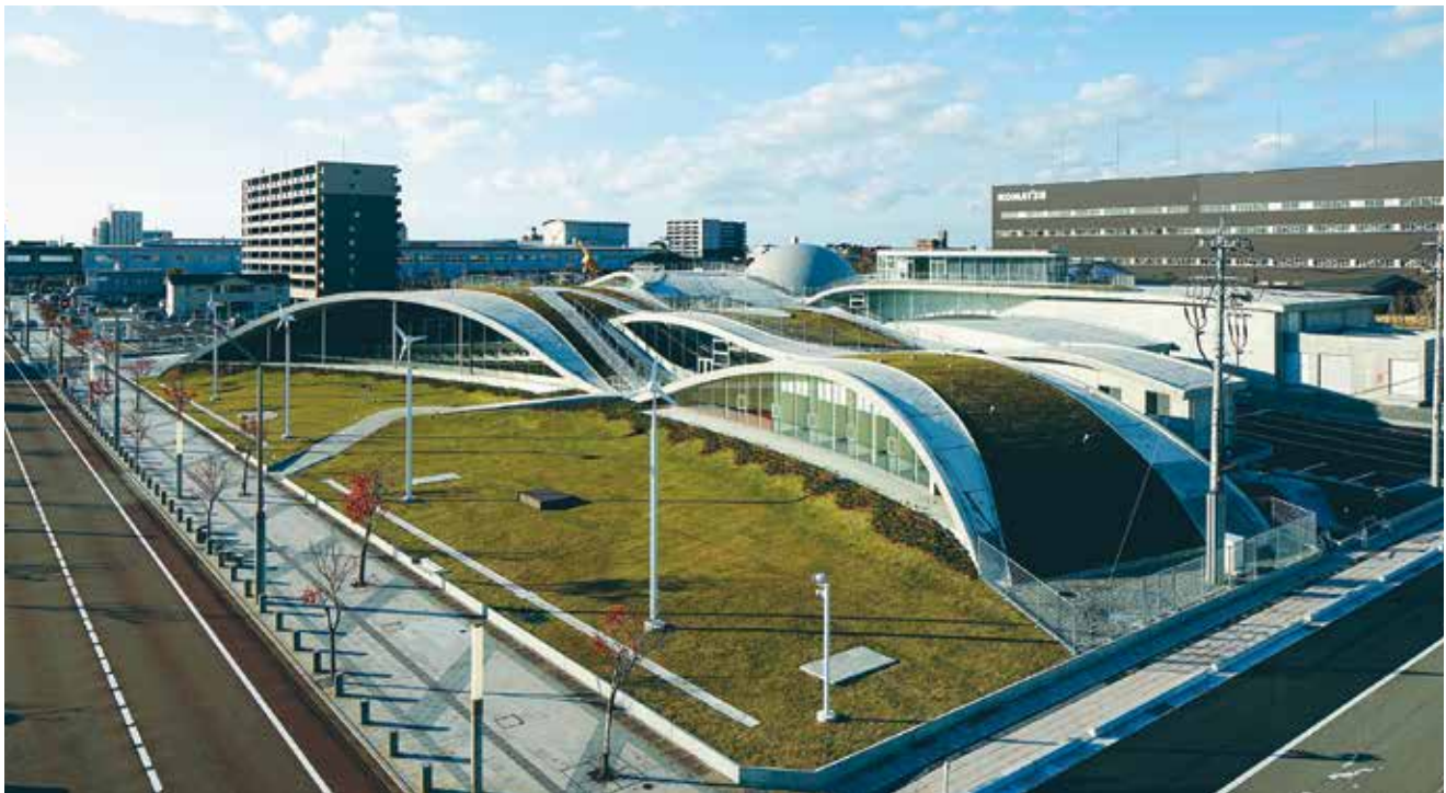
外観・南東側俯瞰(左奥方向がJR小松駅)
