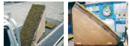
屋上緑化のモックアップ
