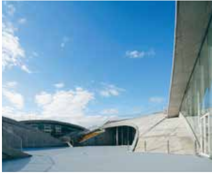
屋上イベントスペース
