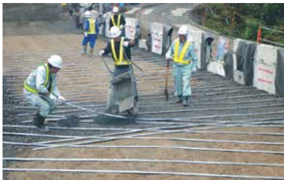
ストリップ敷設作業
