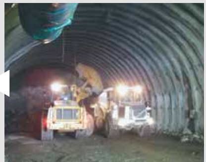
トンネル掘削土搬出
