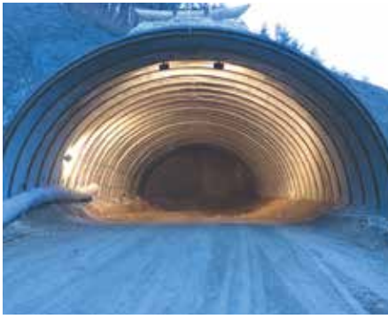
八雲第3トンネル施工状況(平成25年12月)
