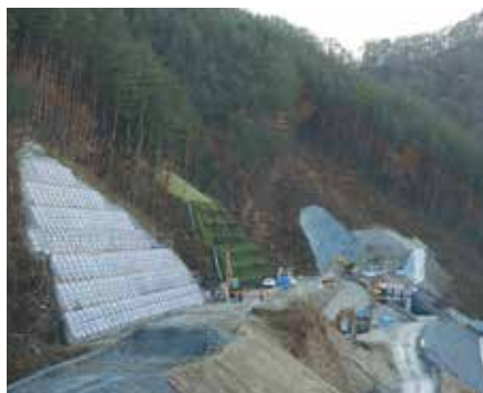
法面抑止工(アンカー工)
