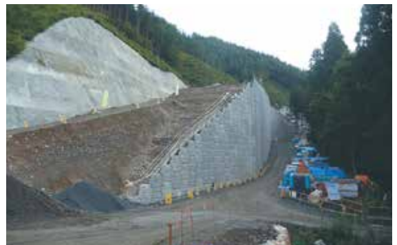
補強土擁壁(テールアルメ)施工状況
