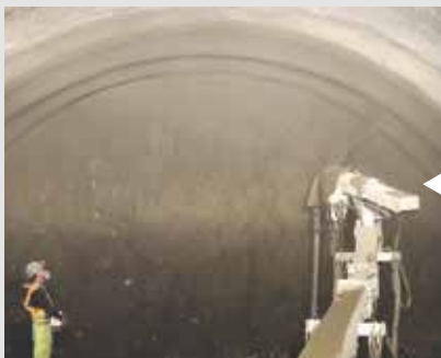
吹付けコンクリート
