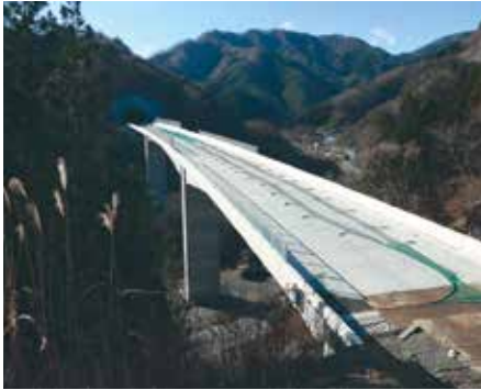
水海高架橋上部工(平成25年3月)
