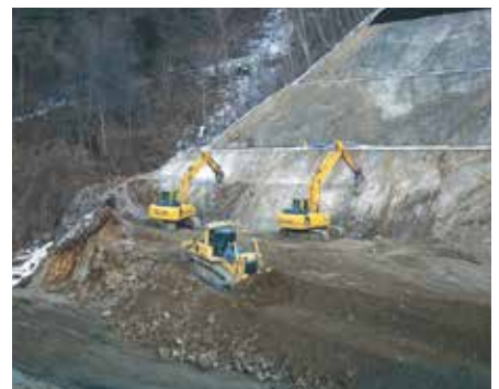
水海地区道路土工掘削状況
