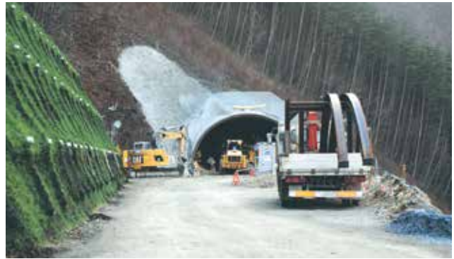
八雲第3トンネル施工状況 (平成25年12月)
