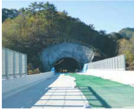
水海トンネル施工状況(平成25年11月)
