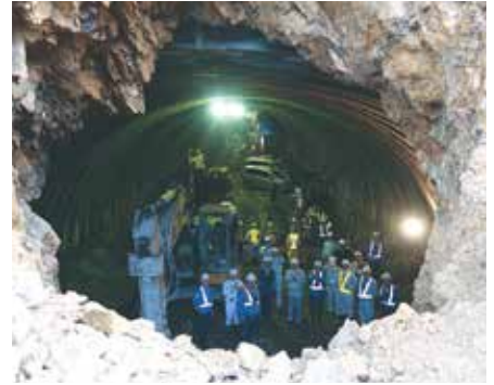
水海トンネル貫通後の坑内を覗く(平成25年10月24日)
