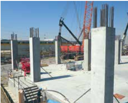
建方初日、PCa柱建込み状況
