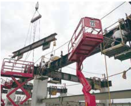
PCa柱・地組梁の精度が良い為、その後の各部材もスムーズに組み立てられていく
