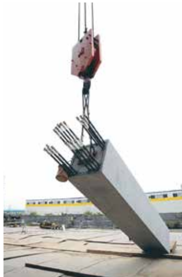
PCa柱の建ちし人扱いは徹底して行われる
