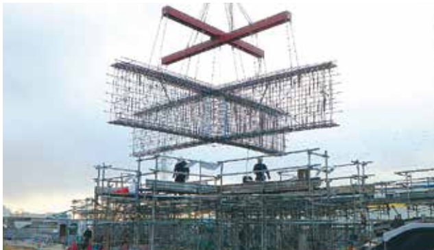
広大な敷地ならではの地中梁鉄筋の地組みを行うことにより、労務の平準化を図った(平成25.1.25)
