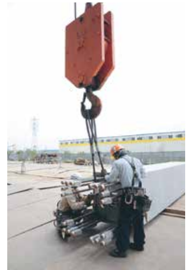
搬入されたPCa柱に建方治具を取付けて3階部分へ
