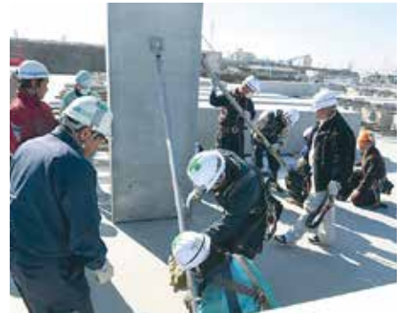
PCaサポートを取付、柱の建入精度を調整する
