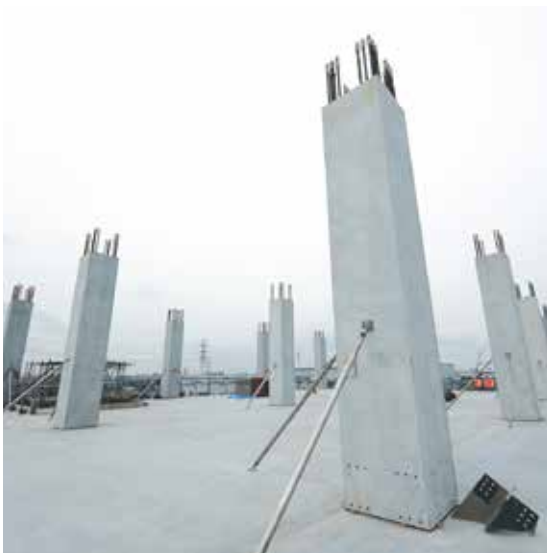
PCa柱が建ち並ぶ3階部分(平成25.6.6現在)
