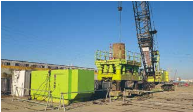
杭の施工精度を向上させる為、事前に地中障害を撤去する(平成24.12.13)
