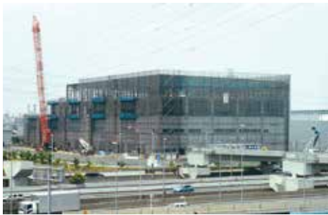
施工中の外観(平成25.6現在)
