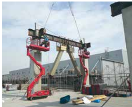
先行して建てたPCa柱に地組した鉄骨を差し込む
