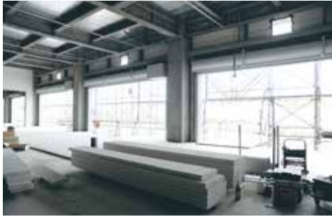
内装工事の準備を待つ1階(平成25.6.6)
