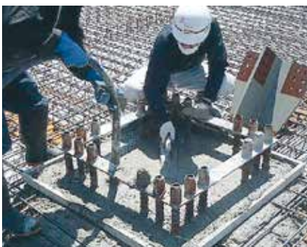
柱仕口部は高強度コンクリートを採用 次工程に引き継ぐ為に、柱鉄筋は治具にて精度を保持、左官工は基準レベルを確認し、構造一体化の為、粗面に仕上げる
