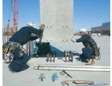
柱下部中央に事前に設置されたライナープレートで柱の高さ、方向の精度を確保する
