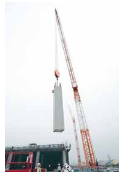
450tクローラークレーンにて揚重
