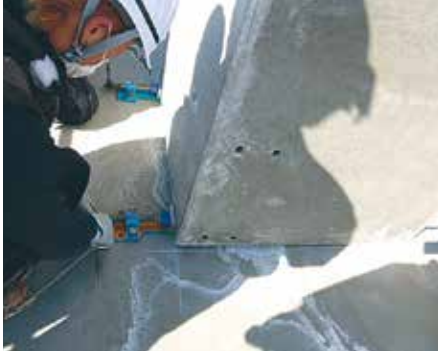
床に書かれた柱の墨にミリ単位での調整を行う
