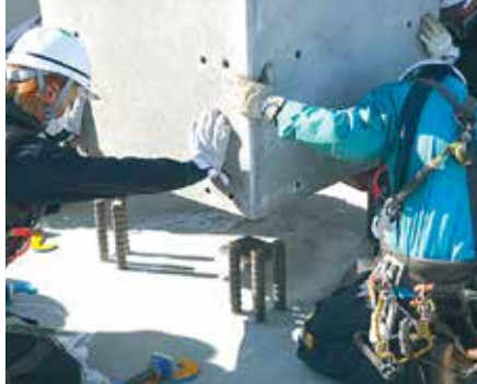
何度も精度確認した柱鉄筋にPCa柱を差し込む、緊張の瞬間
