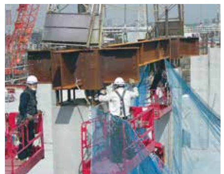
安全設備を先行設置する為、水平ネットも予め地組梁に取り付け揚重する
