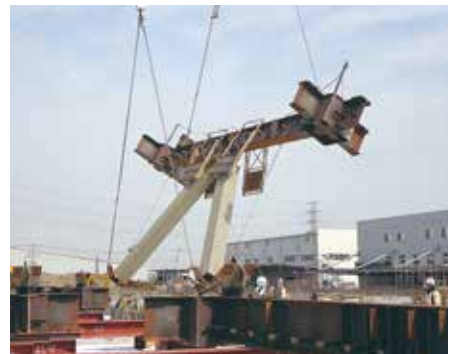
柱仕口、大梁、鉛直ブレースを安全な地上で地組・本締めを行い、一気に揚重
