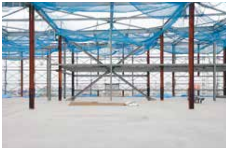
4階は通常の鉄骨造となる(平成25.6.6)
