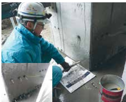
PCa柱を固着させる為に、各柱鉄筋廻りにグラウト材を注入
