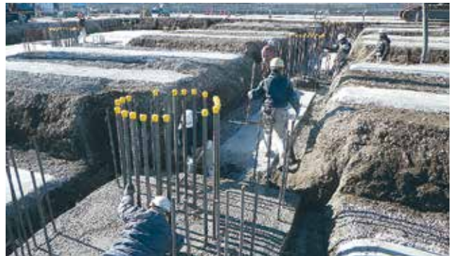
地上PCa柱の精度に大きく影響する柱鉄筋を精度良く建込む為、基礎を2回に分けて打設する*PCa:プレキャスト(平成24.12.26)
