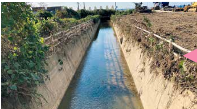
応急復旧完了
