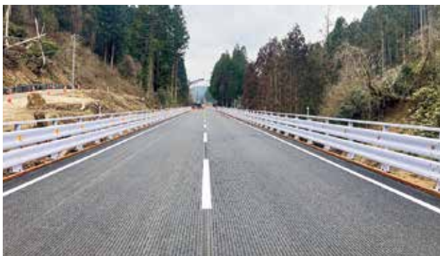
国道249号中屋トンネル東工区開通（2025.3.31）
