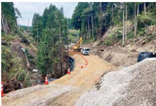
道路拡幅状況
