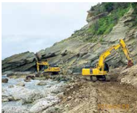
逢坂トンネル復旧工事施工状況
