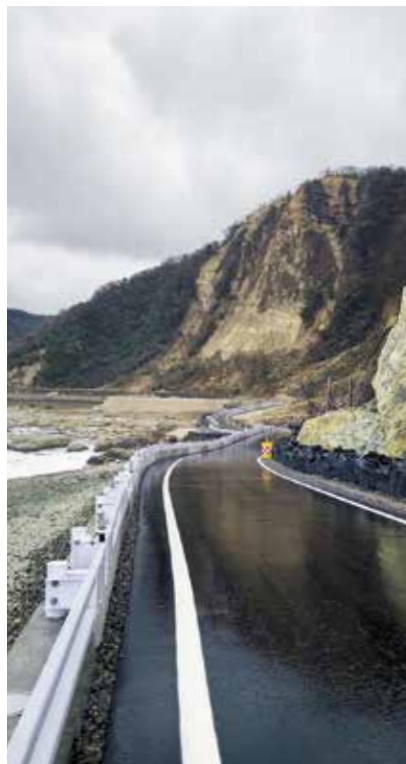
国道249号逢坂トンネル工区開通（2024.12.27）
