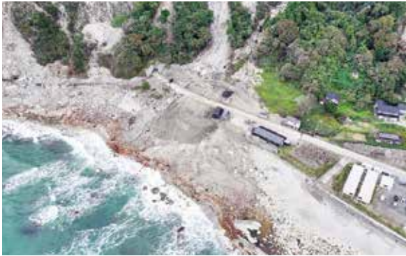
八世乃洞門新トンネル周辺：啓開完了
