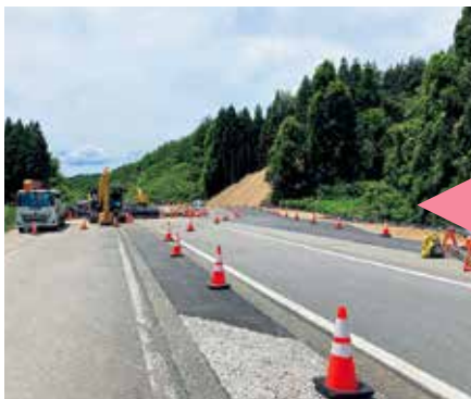
応急復旧完了
