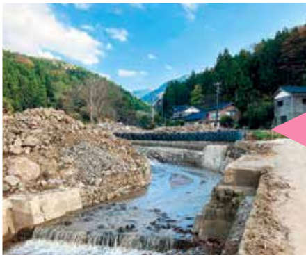
応急復旧完了
