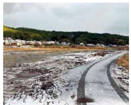
農地被害：長井町（応急復旧完了）
