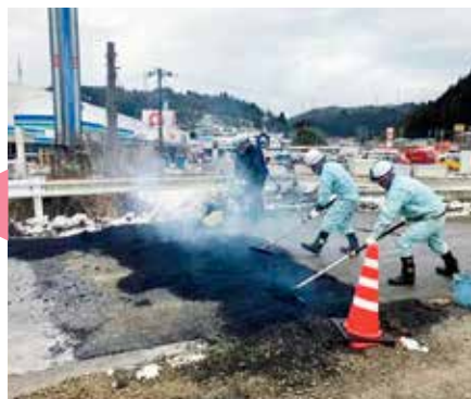
能越自動車道施工状況
