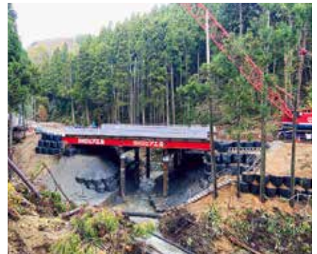
中屋トンネル東工区：仮設橋梁設置完了
