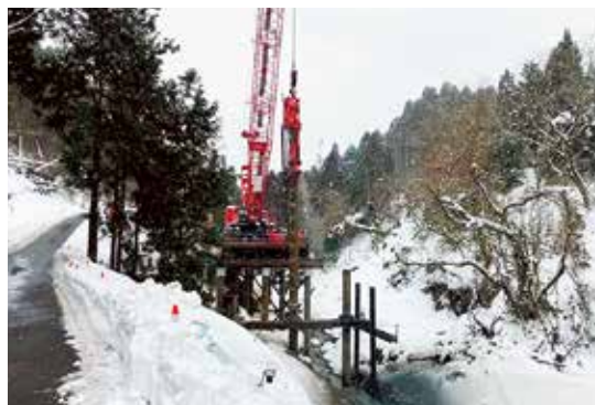
積雪のなかでの施工状況(国道249号 中屋トンネル東工区)
