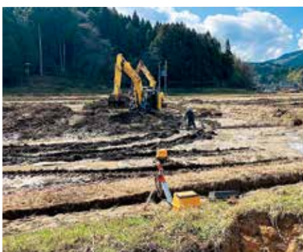
下黒川町（施工中）
