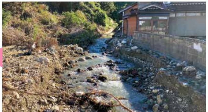
真浦川：被災状況
