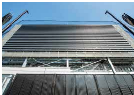
スコアボード背面の太陽光パネル(完成)
