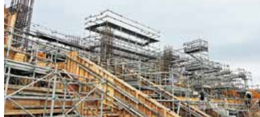
スタジアム内躯体工事
