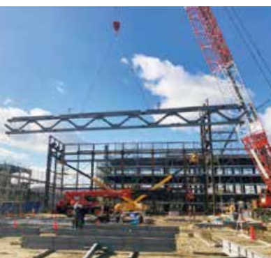
室内練習場鉄骨建方施工
