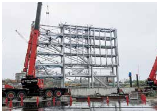
スコアボード棟鉄骨工事 背面に太陽光パネルを設置
