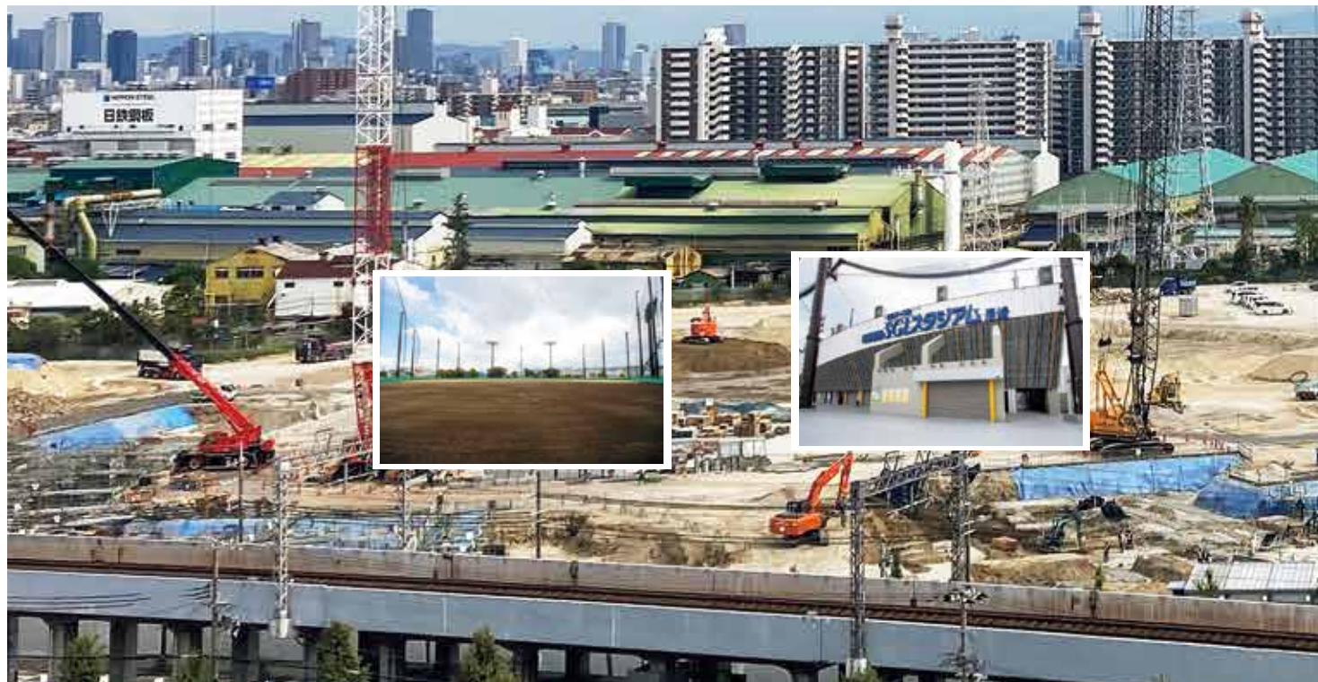
施工風景(全景)
