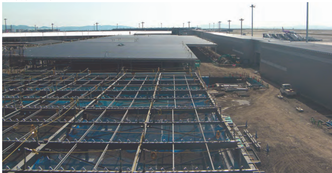
施工風景：敷地南側より(エアサイド) コンコース棟エアサイド側舗装完了 (2016.4.15)
