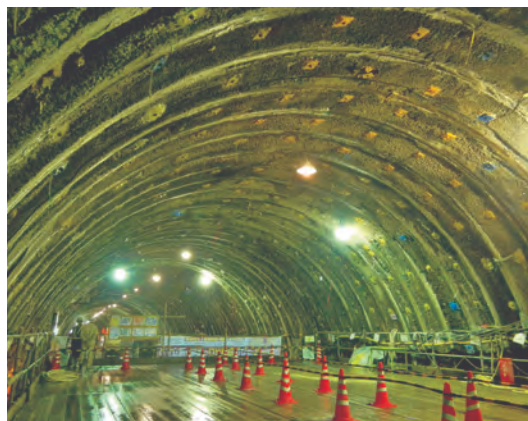
減水対策工後（天端等からの滴水がほとんどない）
