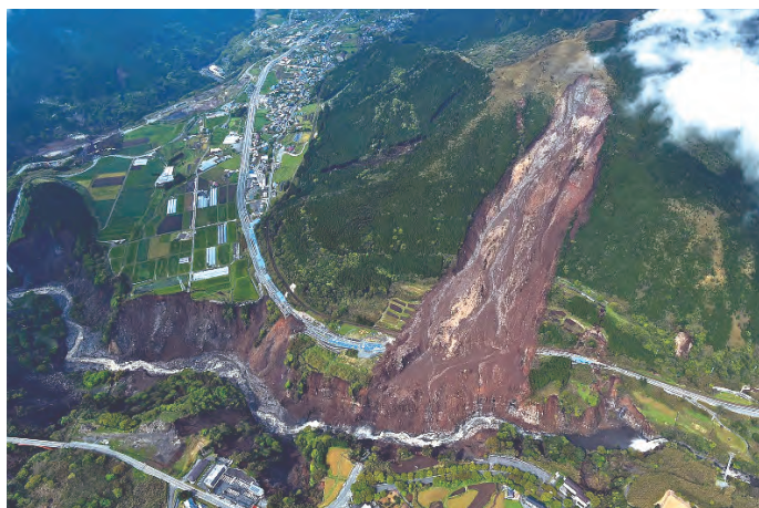
阿蘇大橋地区土砂崩壊現場
