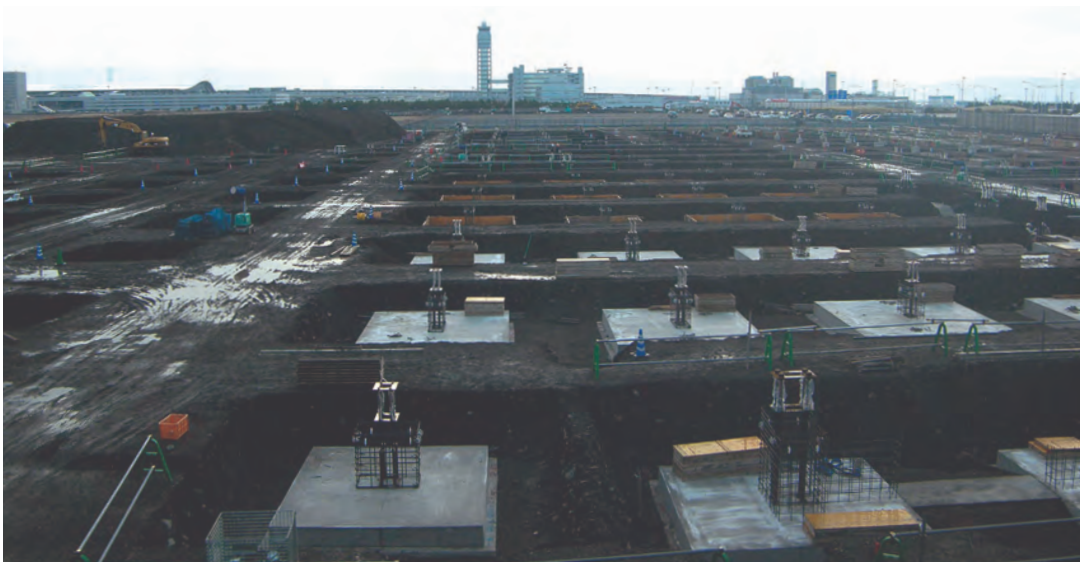
施工風景：敷地西側より ターミナル棟基礎工事中 (2015.12.25)
