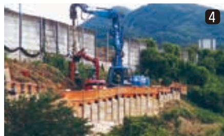
4 ダウンザホール工法による遮音壁・鋼管杭
