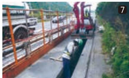
7 支障物移設工(通信管路)作業状況
