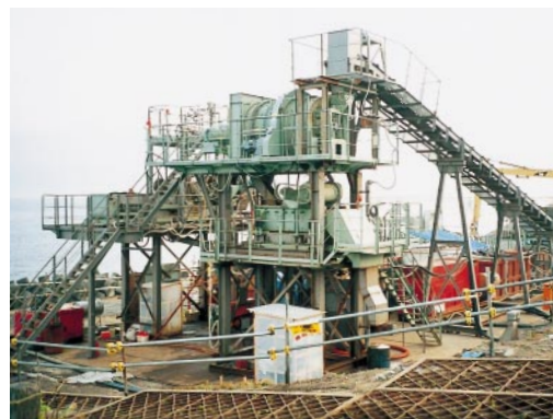
SRS全景 (原油汚染土壌浄化工事)
