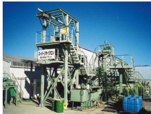
豊川実証プラント (浄化確認試験を行います。)
