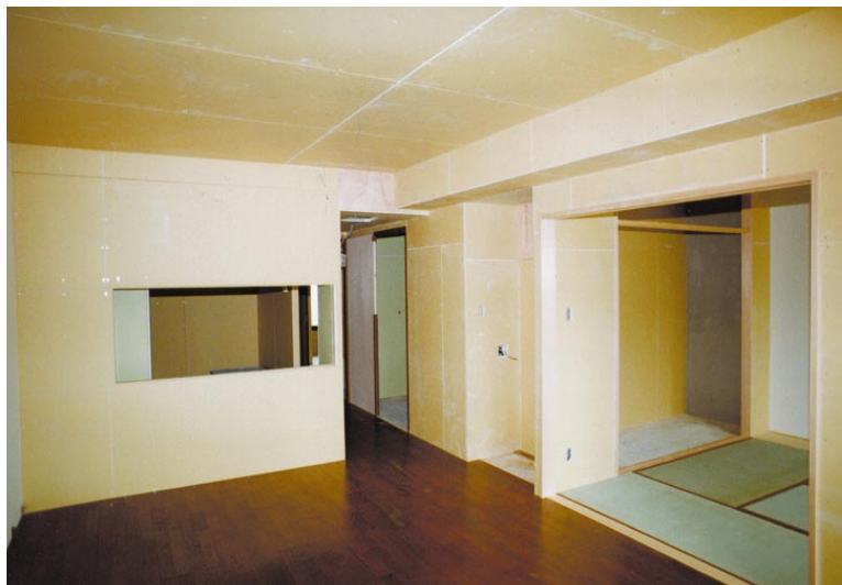
床先行乾式遮音二重床 施工例
