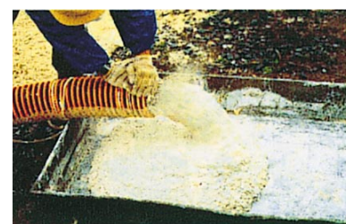
ポンプ打設状況
