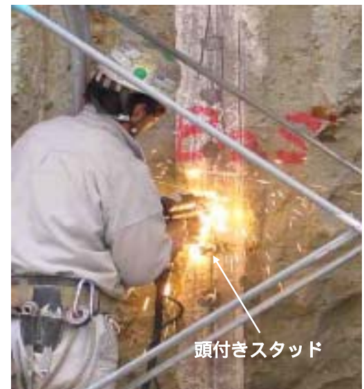
スタッドの溶接状況
