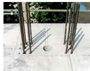
スラブのコンクリート注入孔・柱筋貫通孔
