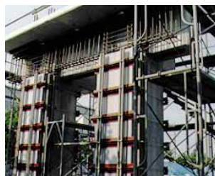
柱打ち込み型枠セット
