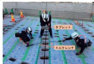
Photo. 2 締付けボルトのトルク管理
