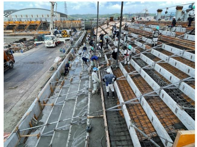
写真22 段床コンクリート打設状況
