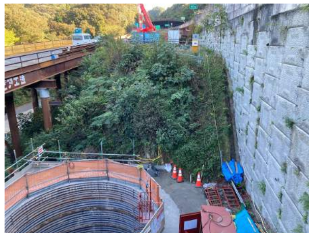
写真-1 深礎杭施工箇所と補強土壁の位置関係
