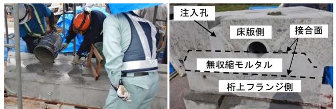
Photo. 2 充填性試験状況
