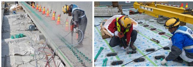
(1) 削孔状況 (2) 鉄筋挿入・エポキシ樹脂注入
