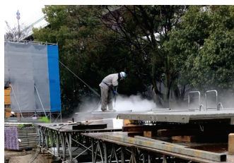
写真6 外壁PCa版仕上げ
