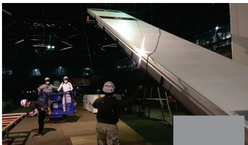
写真7 大型可動間仕切 取付け状況
