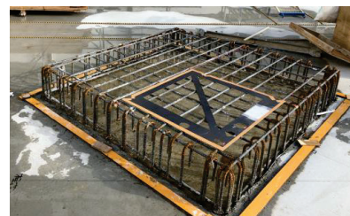
1/4テンプレート(上写真は1階立上り打設後確認状況)
