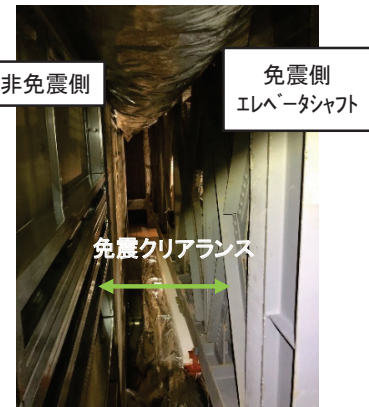
エレベーターシャフト内見上げ
