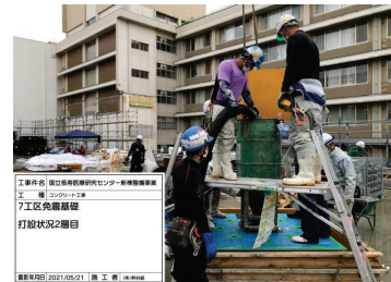
実施施工(2層目)
