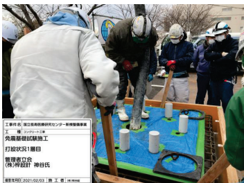
試験施工(1層目)
