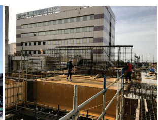
梁鉄筋先組状況
