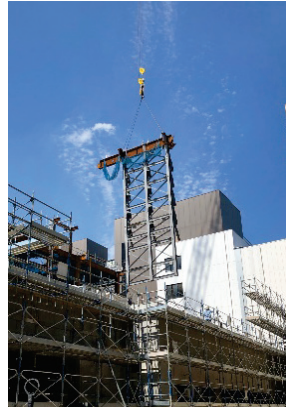
地組揚重状況
