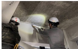
写真10 躯体取合処理
