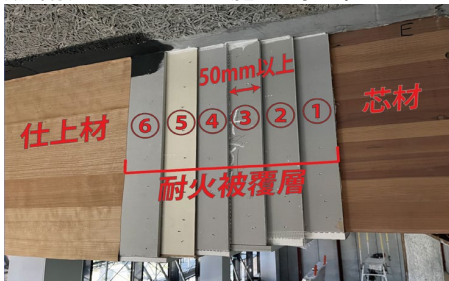
写真8 2時間耐火(梁)断面
