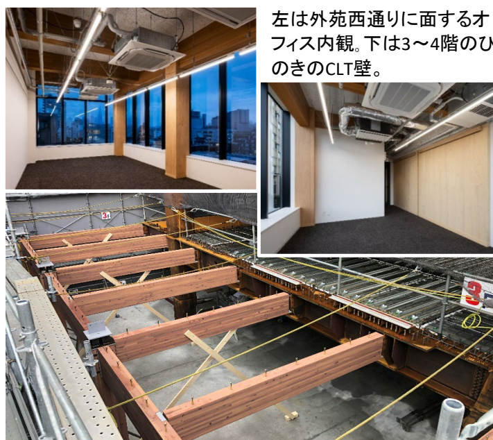
写真2 木造架構部施工状況
