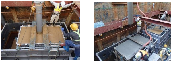
写真-2 現場打設実験の状況
