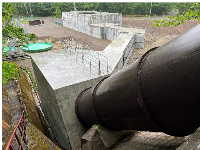
Photo. 9 発電所完成全景
