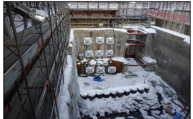
Photo. 2 グラウンドアンカー設置状況
