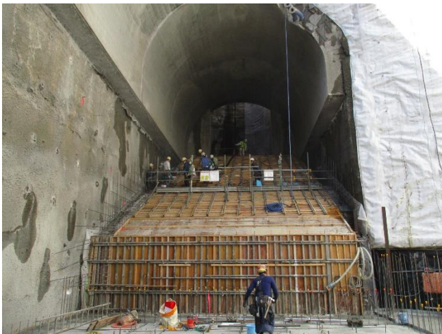
Photo. 6 放水池インバート施工状況
