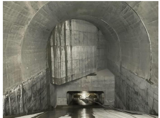
Photo. 7 放水池トンネル施工完了
