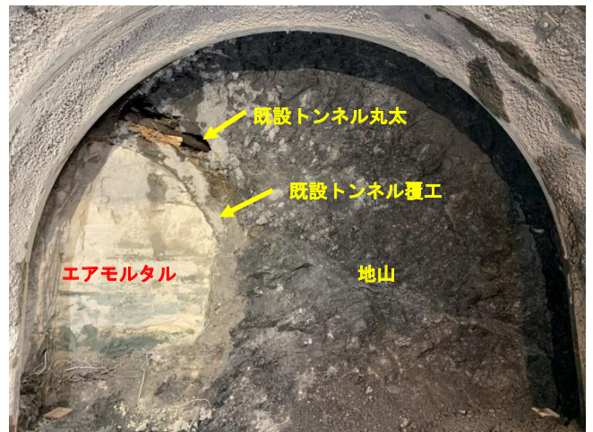
Photo. 8 放水路トンネル切羽
