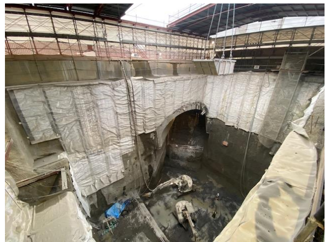
Photo. 1 発電所掘削状況
