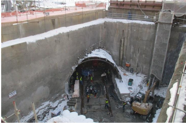
Photo. 5 放水池トンネル施工状況
