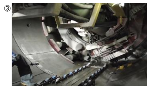
Photo. 4 下部セグメント組立て完了
