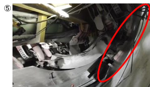
Photo. 6 同時掘進 セグメント組立て完了
