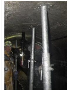
Photo. 10 パイプサポートによる補強
