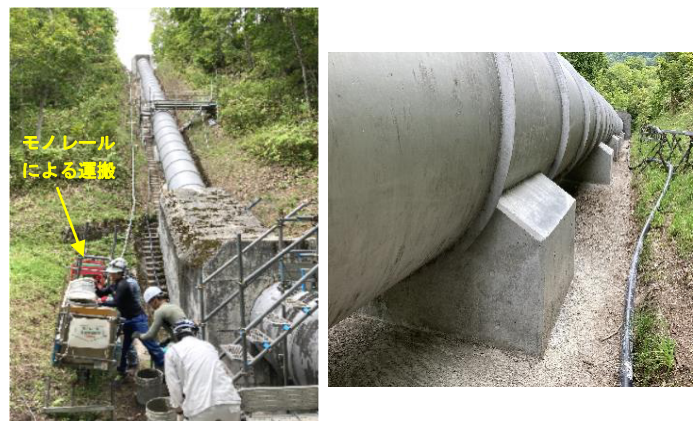
Photo. 3 コンクリート運搬状況 (左) と補修完了状況 (右)
