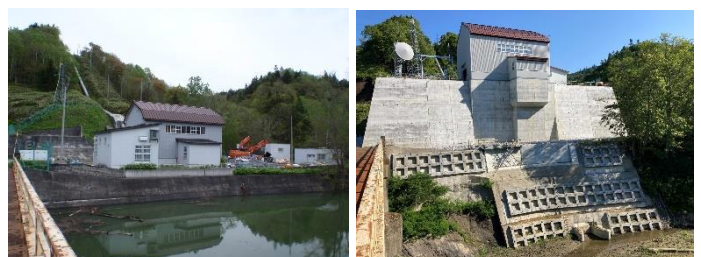
Photo. 1 熊追発電所 着工前（左）と完成後（右）
