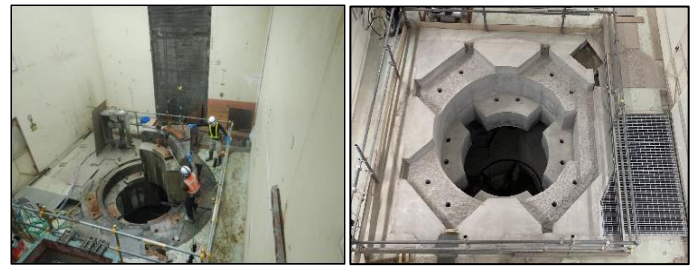
Photo. 2 既設スラブ撤去状況 (左) と新規構築状況 (右)
