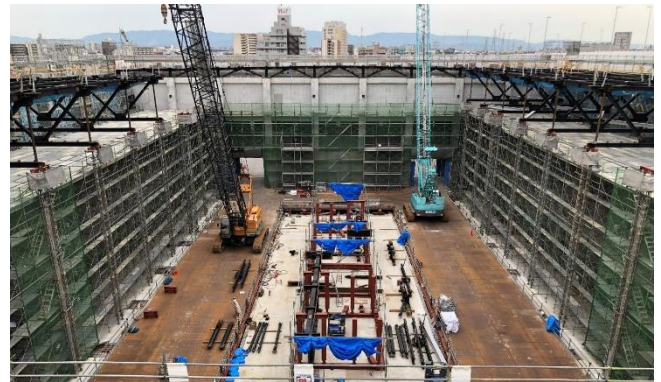
Photo. 12 両端部鉄骨トラス地組, 取付
