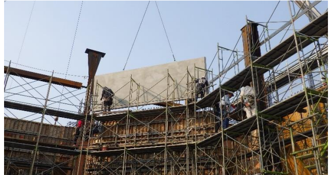
Photo. 10 PCa部材据付状況
