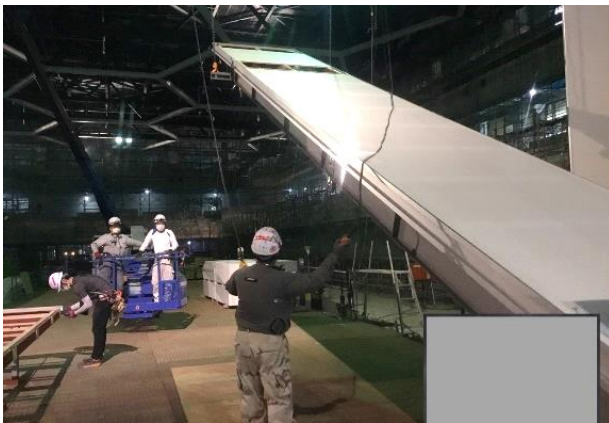
Photo. 15 可動間仕切 取付状況
