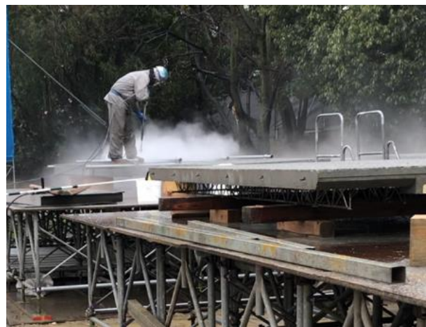
Photo. 7 ウォータージェットピーリング
