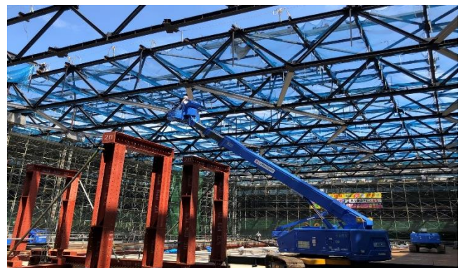
Photo. 14 鉄骨トラス本締め
