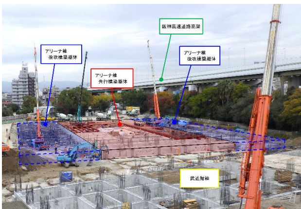
Photo. 4 地下躯体工事
