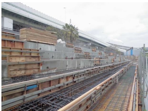
Photo. 6 PCa部材据付後
