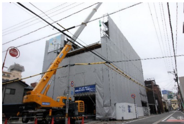
Photo. 10 70 t クレーンによる木部材建方
