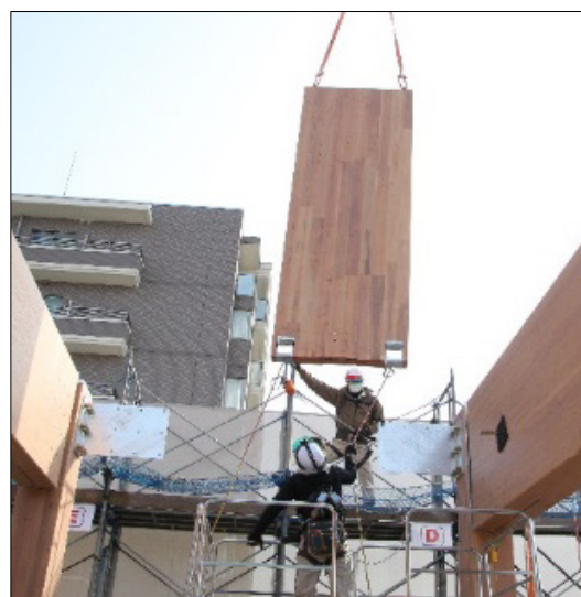
Photo. 17 パワークランプを使用した建方状況
