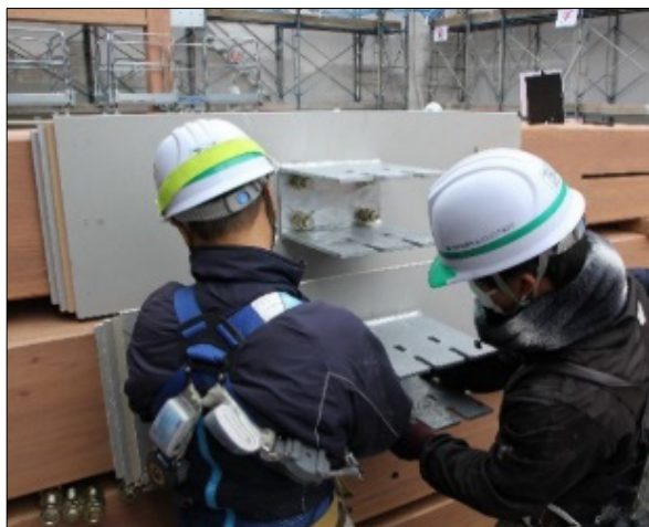
Photo. 15 通しボルト干渉部先行耐火処理
