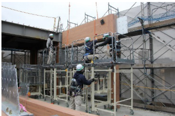
Photo. 8 建方時の仮設設備
