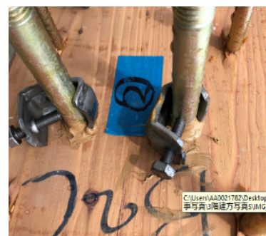
Photo. 6 ボルト貫通部のシール処理
