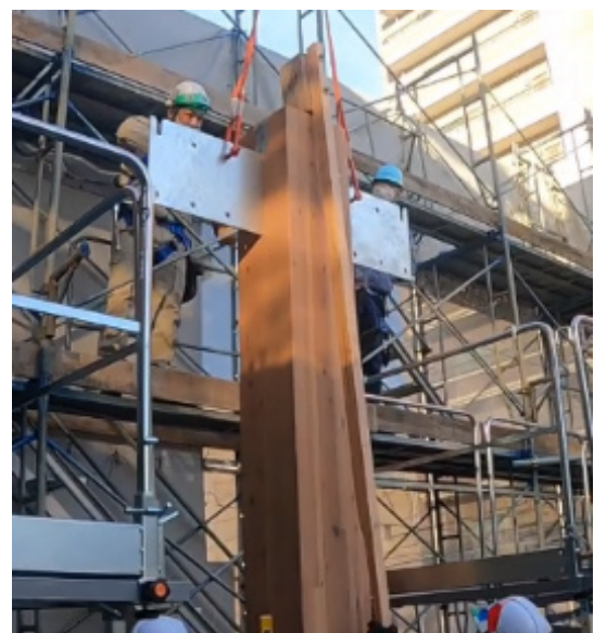
Photo. 14 「逆さ掛矢」使用状況
