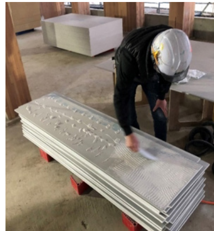
Photo. 20 接着材塗布状況
