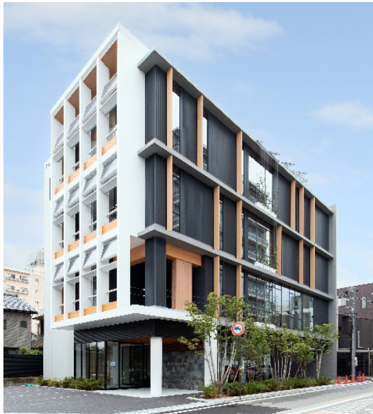
Photo. 1 熊谷組福井本店 外観(東南面)
