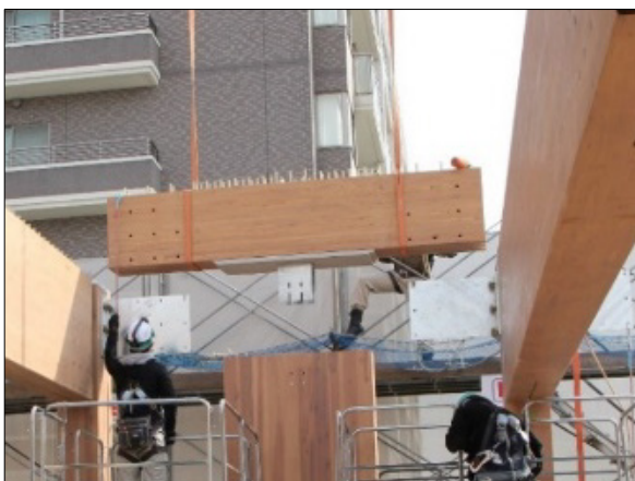
Photo. 16 木部材(梁)の建方状況 (耐火被覆のボードは後施工)
