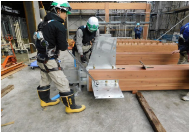
Photo. 11 接合金物先行取付状況
