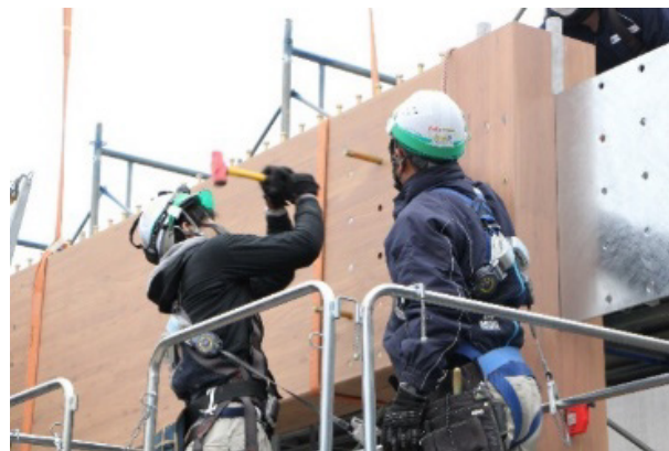
Photo. 9 ドリフトピン打込状況
