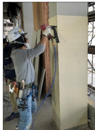
Photo. 22 3枚目断熱耐火パネル施工状況
