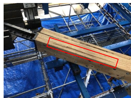
Photo. 2 圧縮側 2.5%ひずみサイクル時 試験体破壊状況写真
