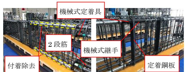
(a) 主筋の付着除去の様子 (b) 中央定着部の様子
