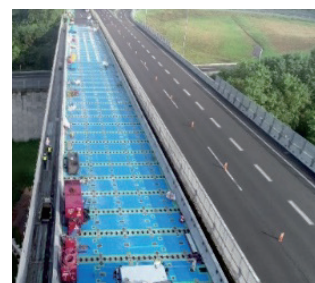
Photo. 15 コッター床版工法作業環境
