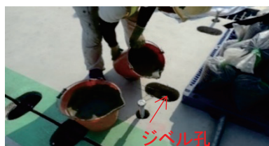
STEP7 床版と鋼桁との接合
