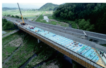
Photo. 19 東北自動車道 床版取替工事
