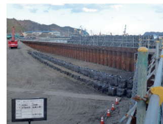
Photo. 10 仮締切内側補強盛土
