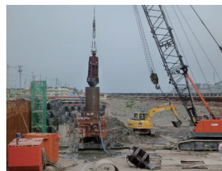
Photo. 13 ケーシング削孔
