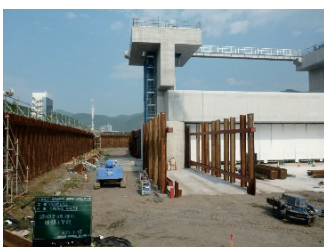
Photo. 3 仮締切支柱材
