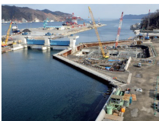
Photo. 5 仮締切堤全景
