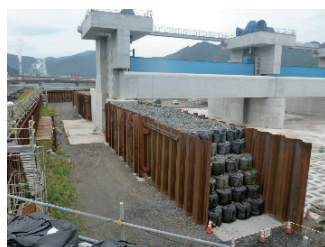
Photo. 4 自立式仮締切堤
