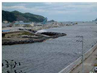
Photo. 7 仮締切越波状況 2015. 10. 8
