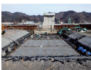
Photo. 6 仮締切堤中央部
