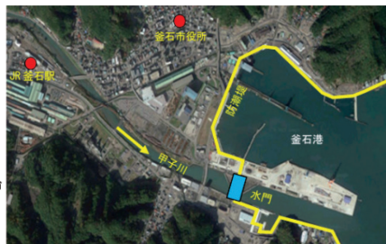
Fig.2 甲子川水門位置(釜石市)
