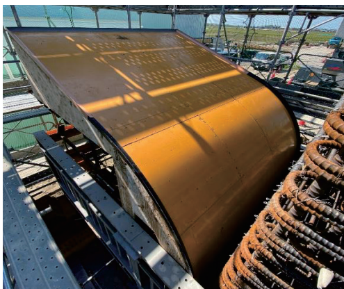
Photo. 19 R 型枠設置状況
