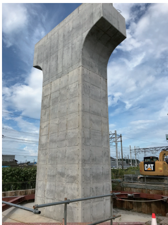
Photo. 9 仕上がり全景
