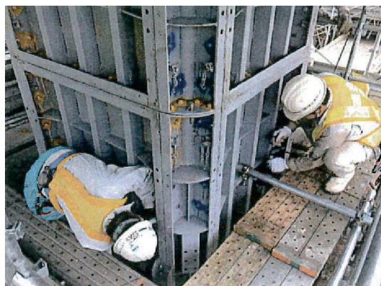
Photo. 13 型枠締めめ状況(表面)
