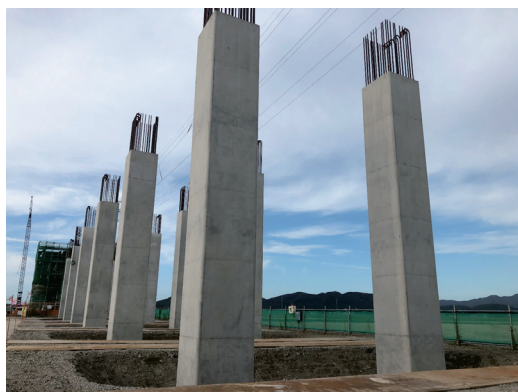
Photo. 16 仕上がり全景
