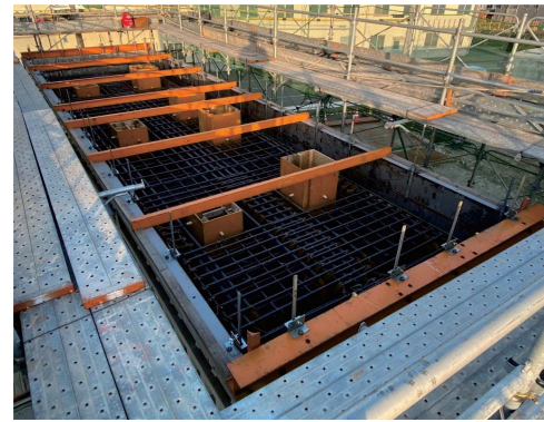
Photo. 20 梁天端型枠設置完了
