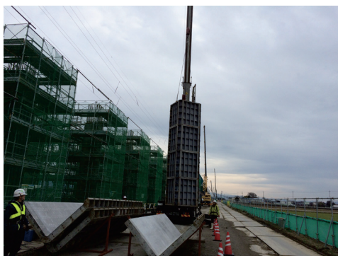
Photo. 10 地組み吊り込み状況
