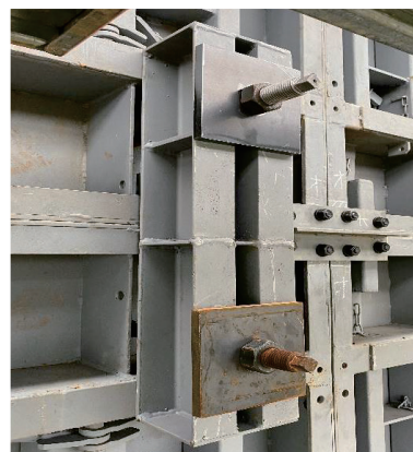
Photo. 18 シーボルト設置状況
