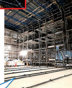
走行式足場は直ぐに解体 下部の施工を並行する
