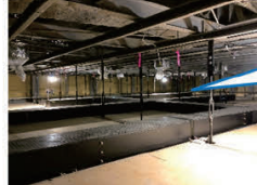
ワイヤリングダクトも先行し て取付できる
