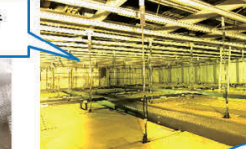
レール走行式移動足場 仮設量が1/4になる
