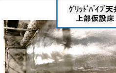
吊り鉄骨を取付後、グリッドパイプ天井をまずつける
