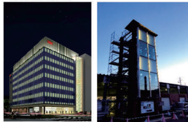
外壁モックアップからデジタルモックアップへ変更の可能性を探った
