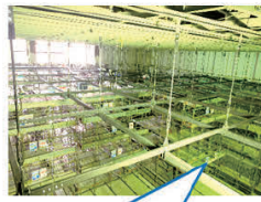
吊り鉄骨を取付後、グリッドパイプ天井をまずつける
