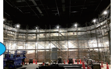
走行式足場は直ぐに解体 下部の施工を並行する
