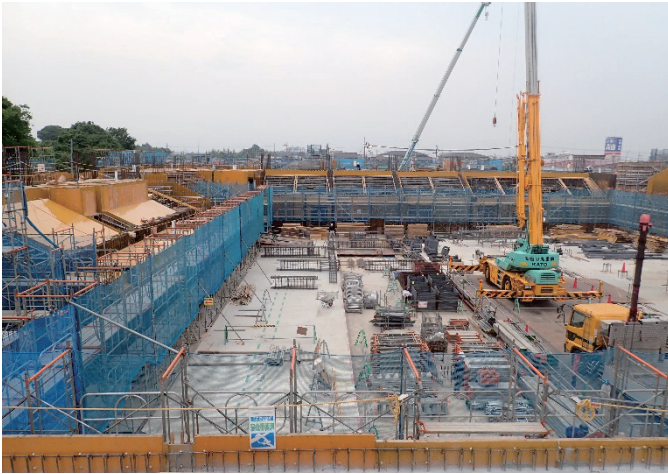
Photo. 2 メインアリーナ内作業状況
