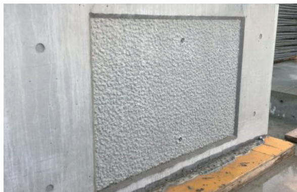
Photo. 5 手すり壁（発泡ポリスチレン製化粧型枠はつり柄）
