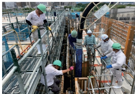
Photo. 6 ライトウェイトホースを用いたコンクリート打設
