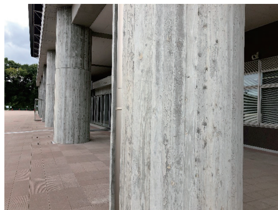
Photo. 7 柱（杉本実型枠）出来型
