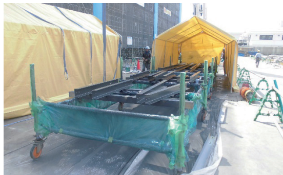
Photo.8 母屋鉄骨塗装ヤード
