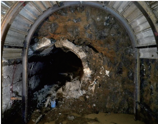
Photo. 15 落盤部掘削工 切羽状況
