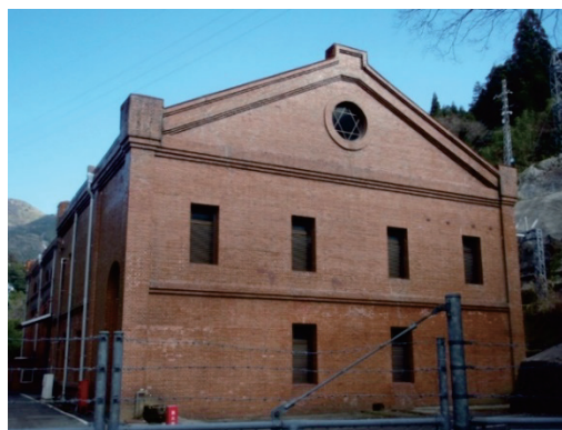
Photo. 1 白川発電所（震災前）
