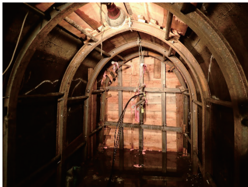
Photo. 18 隔壁設置工施工状況
