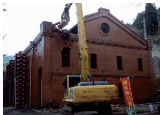
Photo. 3 建屋取壊し状況
