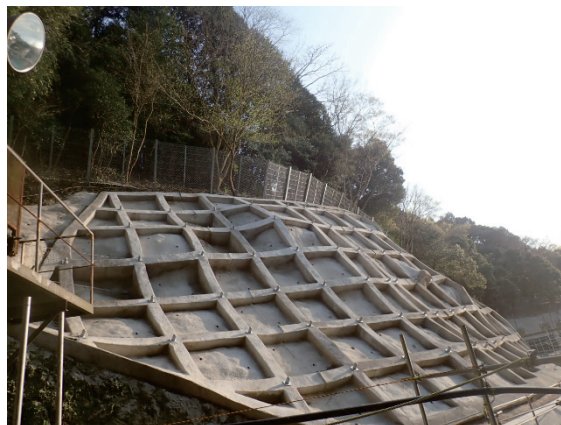
Photo. 7 水槽山側法面保護工 完了
