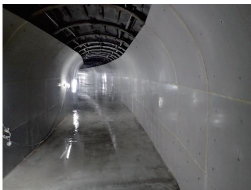
Photo. 22 側壁パネルライニング 完了
