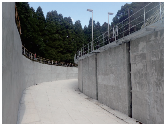
Photo. 9 水槽内部補修 完了
