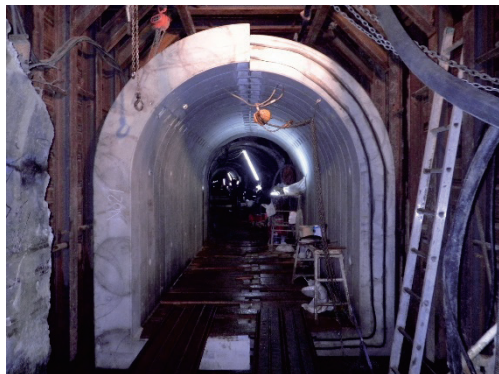
Photo. 24 プレキャスト設置状況
