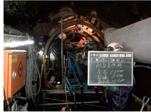
Photo. 19 薬液注入工施工状況
