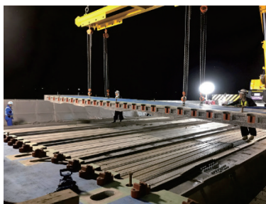
コッター床版架設状況
