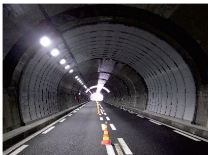
Photo. 1 内巻補強工完了 (辰野トンネル)
