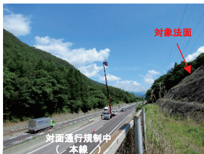
Photo. 2 赤外線調査実施状況 (吹付コンクリート対策工，切土部)
