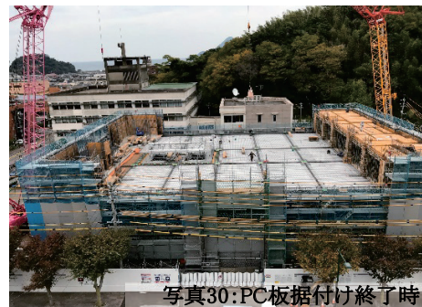
写真30: PC板据付け終了時
