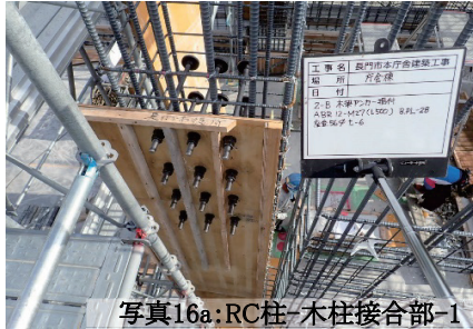
写真16b: RC柱-木柱接合部-2
