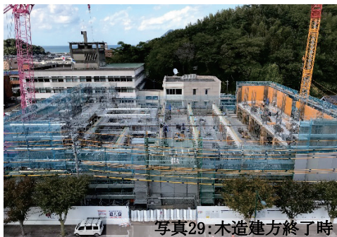
写真29: 木造建方終了時
