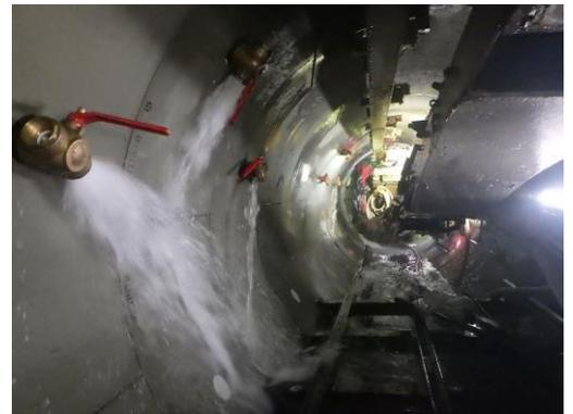
写真-1 切羽水抜き状況
