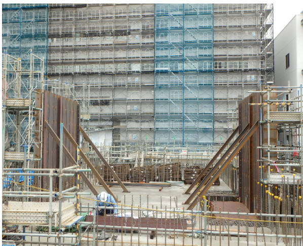
Photo. 11 リニアック室遮蔽鋼板状況
