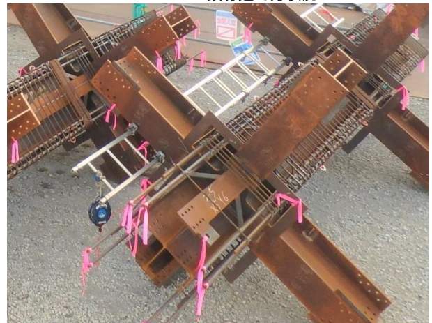
Photo. 7-2(a) 鉄骨梁デッキ受け取り付け状況 1
