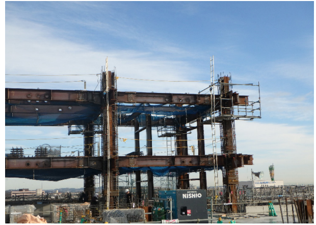
Photo. 7-1 鉄骨建て方状況
