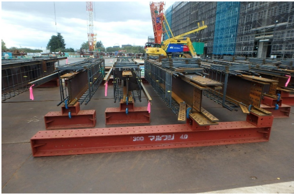
Photo. 5 梁配筋地組状況
