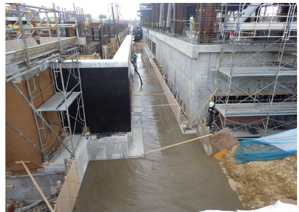
Photo. 10 流動化処理土埋戻し状況
