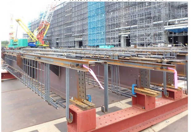
Photo. 7-2(b) 鉄骨梁デッキ受け取り付け状況 2
