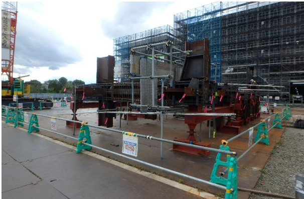
Photo. 6 柱配筋地組状況
