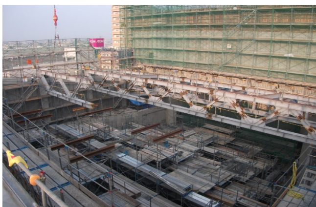
Photo. 3 鉄骨建方状況
