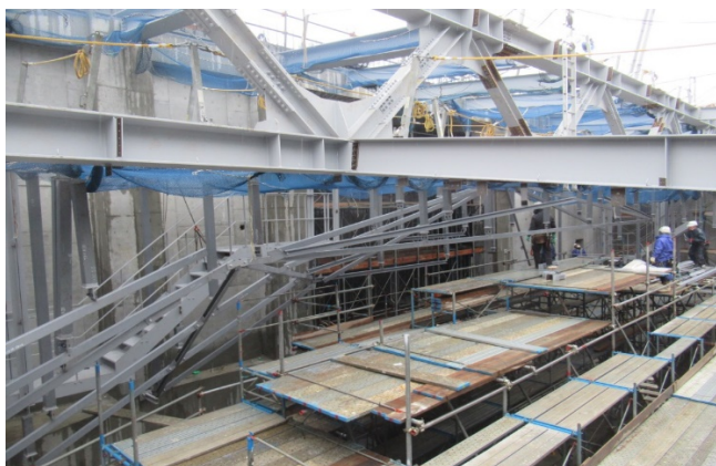
Photo. 4 歩廊、鉄骨 2 次部材組立状況
