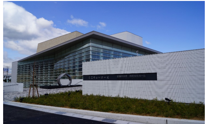
Photo. 11 外観完成写真
