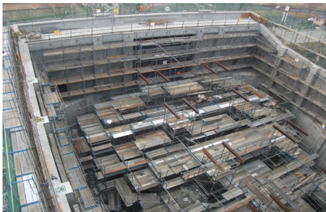
Photo. 2 鉄骨建方前棚足場組立状況
